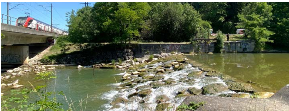
Bei diesem Wehr in der Töss bei Winterthur (hier bei Niedrigwasser) sollen zwei stehende Wellen entstehen, eine für Kanuten, die andere für Surfer. (Foto: aaj)
