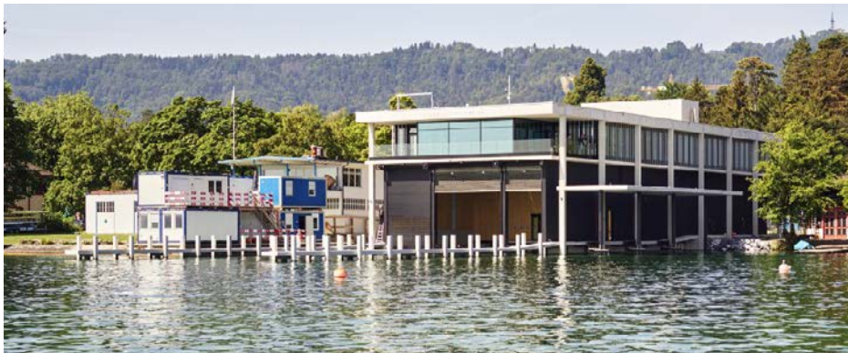
Blick auf die neue Wache der Wasserschutzpolizei am Mythenquai. Die Baucontainer links verschwinden noch. (Foto: zVg Stadt Zürich/Roland Bernath)
