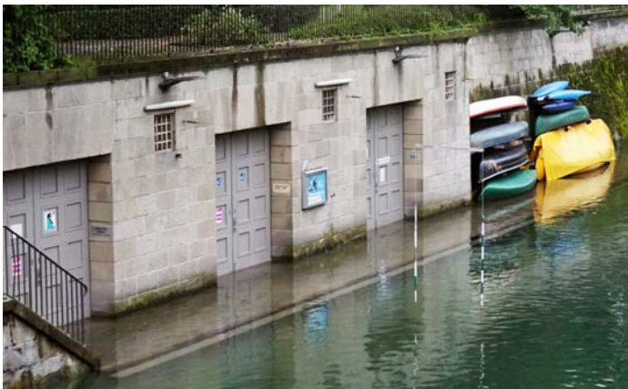
Der Seespiegel ist so hoch, dass das Wasser ins Bootshaus Schanzengraben fliesst.
