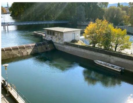
Der Oberwasserkanal (vorne) ist durch ein Dachwehr, das normalerweise am Flussgrund liegt, abgesperrt, und der Wasserpegel ist abgesenkt. Das ganze Limmatwasser fliesst über die beiden anderen Dachwehre in die Sihl (Mitte rechts).
