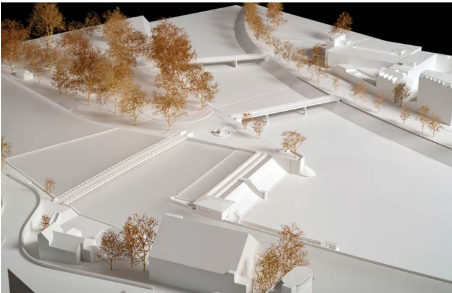
Modell des sanierten Platzspitzwehrs. Über die Sihl führen neu zwei Brücken: der flussaufwärts versetzte historische Mattensteg und eine lastwagengängige Zufahrtsbrücke. (Foto: Modellbau Zaborowsky GmbH/Duri Hess)
