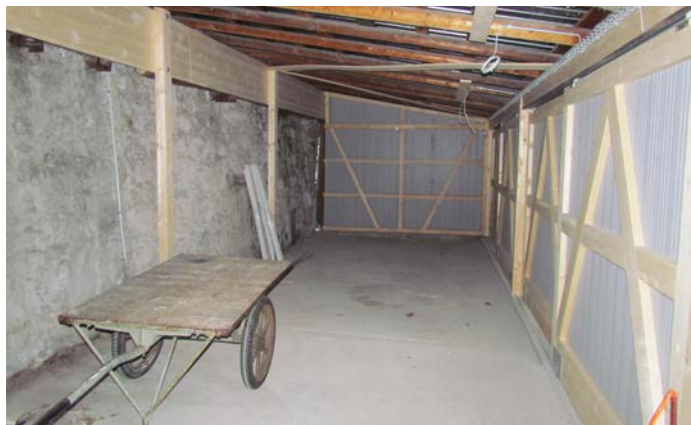
Das Innere der umgebauten Bootshäuser, hier noch ohne Bootsgestelle.
