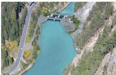
Visualisierung des im Bau befindlichen, 15 Meter hohen Wehrs am Inn bei Ovela. (Bild: GKI)
