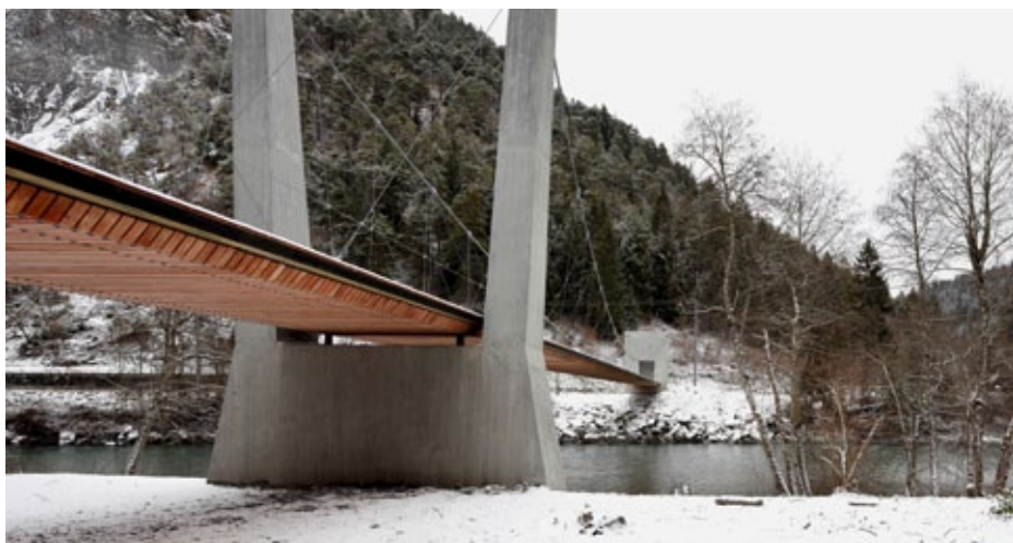
Die Hängebrücke bei Trin Station ist Teil des nunmehr durchgängigen Wanderwegs in der Vorderrheinschlucht zwischen Ilanz und Reichenau. (Fotos: Walter Bieler AG)
