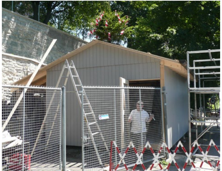
Das neue Bootshaus steht. Man beachte das Aufrichte-Bäumchen auf dem First! (Fotos: aaj)
