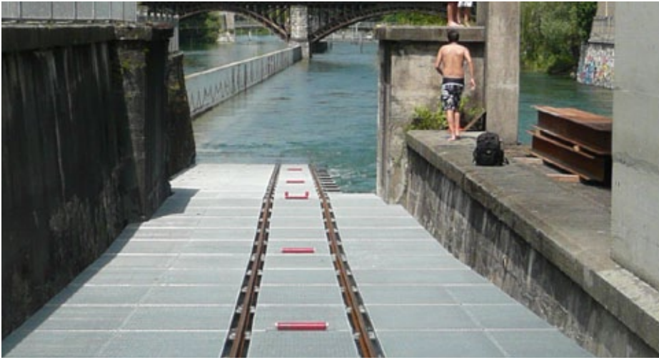
Die neue Fischtreppe beim Kraftwerk Letten befindet sich unterhalb der Kahnrampe. (Fotos: ajj)
