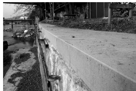
Die Ufermauer wurde instand gestellt und erhielt neue Deckplatten.
