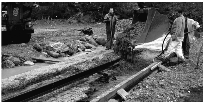
Grosse Betonelemente aus der Liquidationsmasse eines Betonwerks konnten für die Sanierung verwendet werden. (Fotos: Peter Brack)
