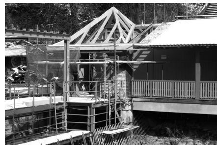
Die vordere Ecke der Badi, die im Juni 2005 in Flammen aufgegangen war, wurde renoviert und erhielt einen neuen Dachstuhl. Die Aufnahme entstand kurz nach den Schneefällen von Ende Februar.
