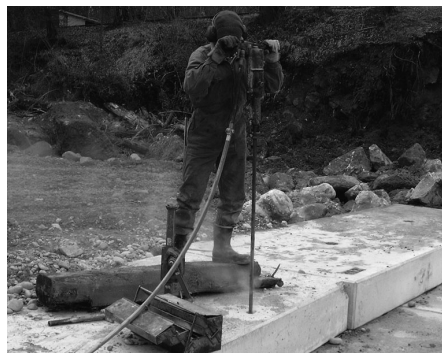
Die Betonplatten wurden mit riesigen Stahlnägeln im Untergrund verankert, damit sie nicht vom Wasser weggeschwemmt werden.
