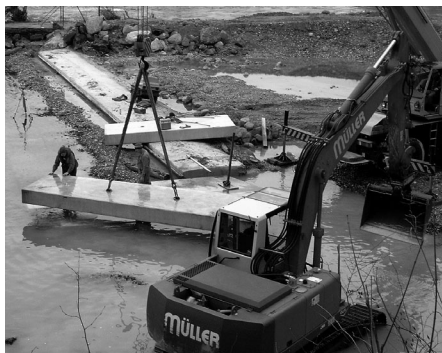
Grosse Betonelemente aus der Liquidationsmasse eines Betonwerks konnten für die Sanierung verwendet werden. (Fotos: Peter Brack)
