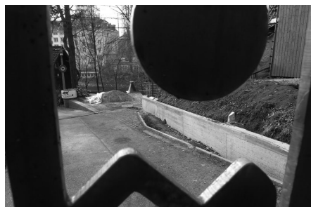
Damit der WVZ-Bootsanhänger besser auf seinen Standplatz manövriert werden kann, wurde die Einfahrt oberhalb des Bootshauses I begradigt (Blick durch das Eingangstor).
