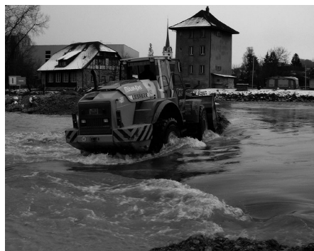
Nach der Instandstellung wurde der Kiesdamm mit einem Schaufellader wieder abgetragen.
