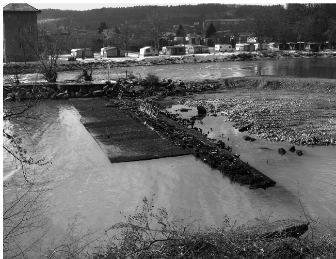
Mit einem Kiesdamm (rechts) wurde Anfang Februar 2006 das Honeggerwehr in Bremgarten trockengelegt. Gut erkennbar ist der abgesunkene Wehrteil in Ufernähe (im Bild rechts unten). Die Fliessrichtung des Wassers ist von rechts nach links. (Foto: aaj)
